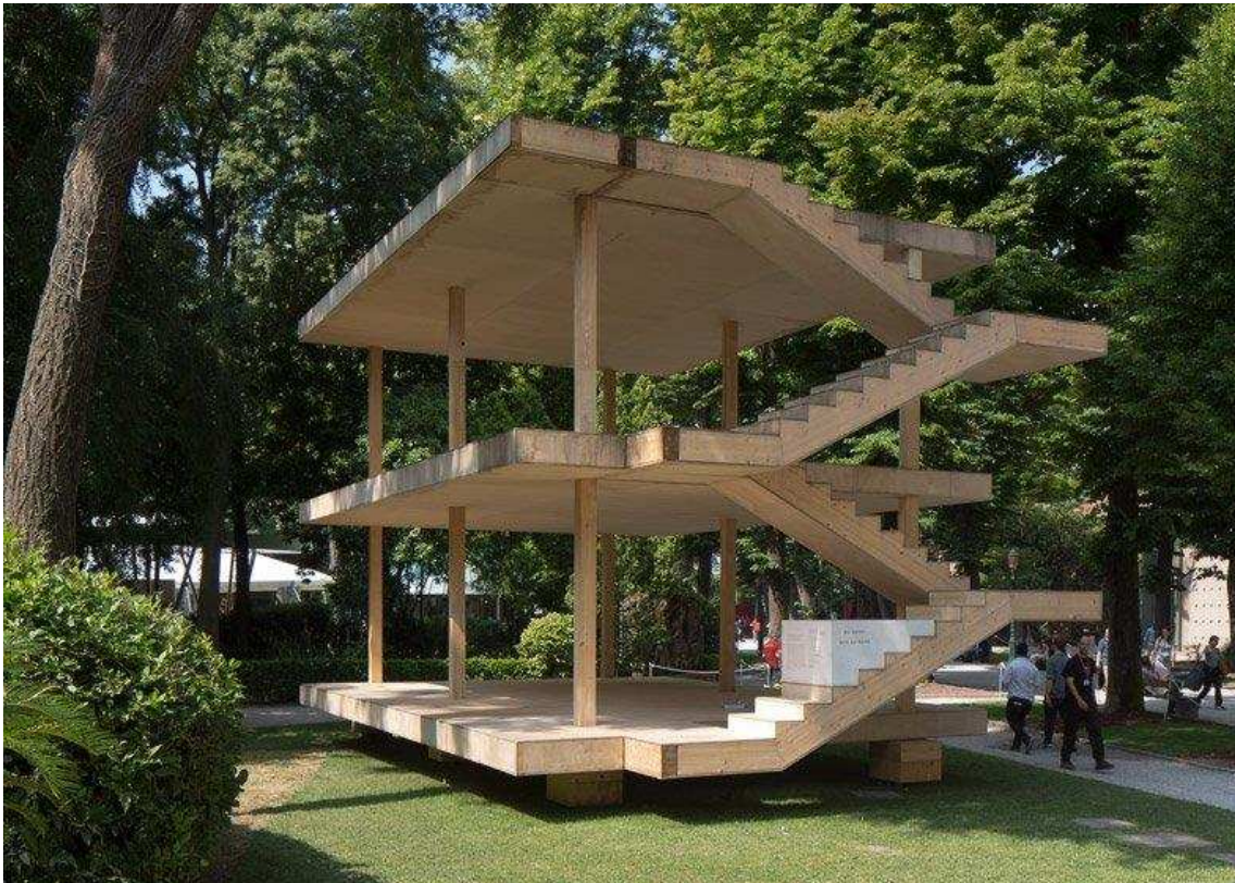
Fig.38. Le Corbusier, Saitama, la casa Dom-ino, 1914.Reproduccion por Jürg Stauffe Imagen recuperada de http://tecnne.com/le-corbusier/dom-ino-uno-a-uno/
