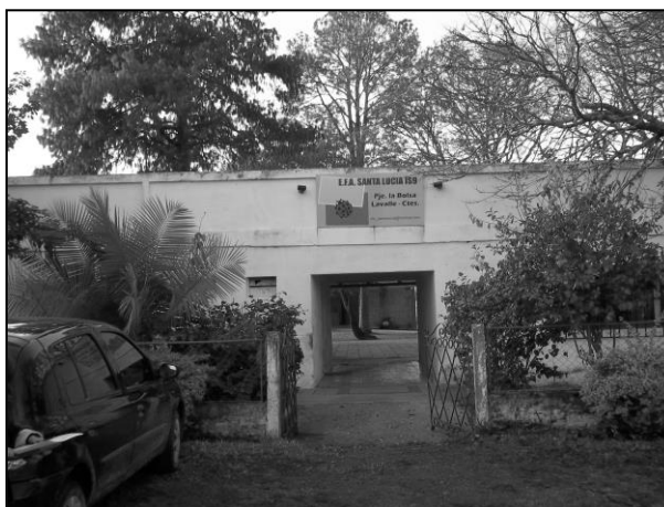
Imagen n° 3: Ingreso EFA Santa Lucía- Fotografía propia 05/07/2016.
