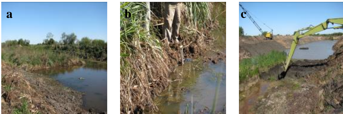
Figura 15. Turba subtropical extraída en forma mecánica. a) y b) Turba subtropical depositada sobre el suelo del arroyo c) Palas mecánicas sacando los sedimentos que se encontraba debajo de la turba, la turba ya fue extraída.
