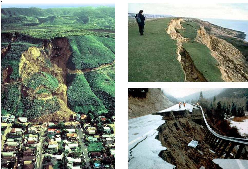
Figura 1.2: Falla debido a inestabilidad en taludes o terraplenes.
