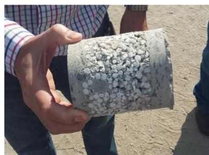
Figura 1: Fotografía de proceso de obra. Corte de panel de hormigón armado.
