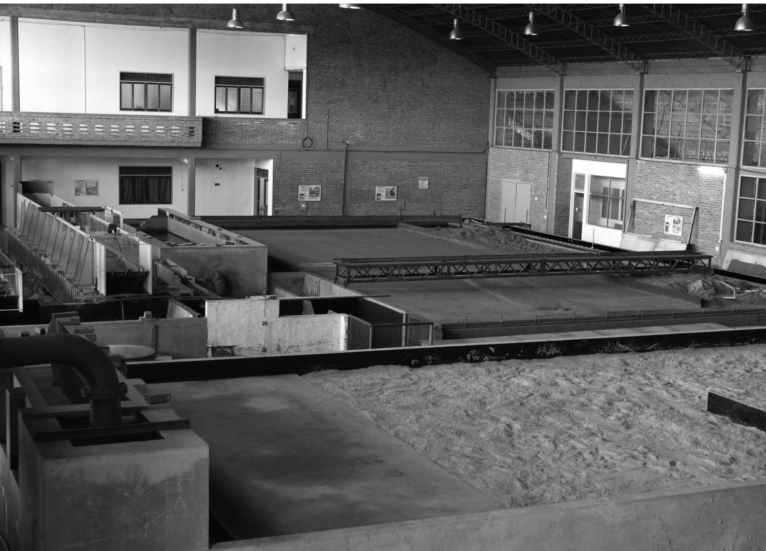
▼ Instalaciones del Laboratorio de Hidráulica hoy.
