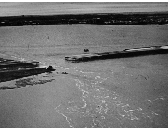
▼ Puente de la autopista Rosario-Santa Fe sobre el río Salado. Caída provocada por la crecida de 1973.
