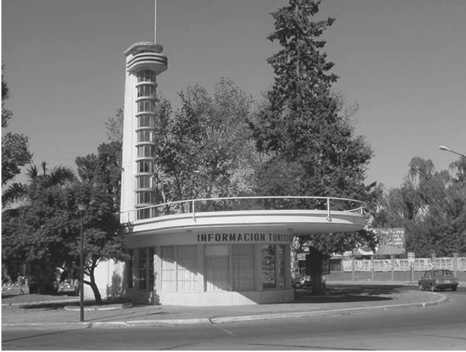
Cabina de Control Caminero.
