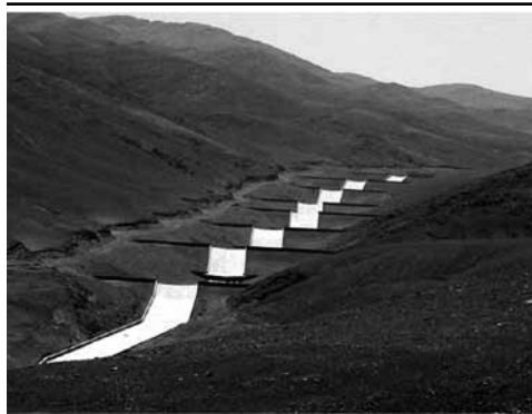
12. Plan Bicentenario. Retardadores de flujos torrenciales, Antofagasta, Chile, 2005.
