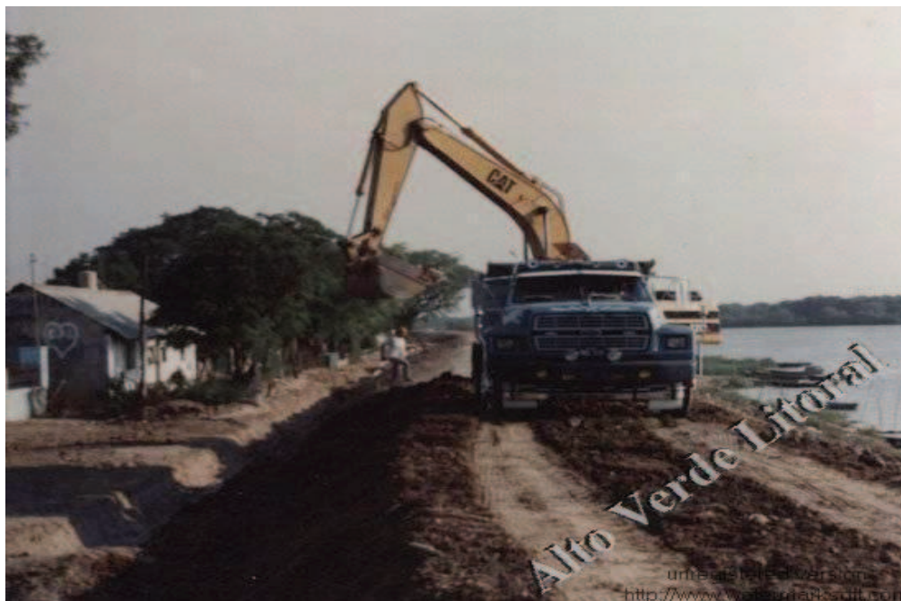
Construcción de las defensas externas Fuente: Perfil de Facebook “Alto Verde Litoral.”
