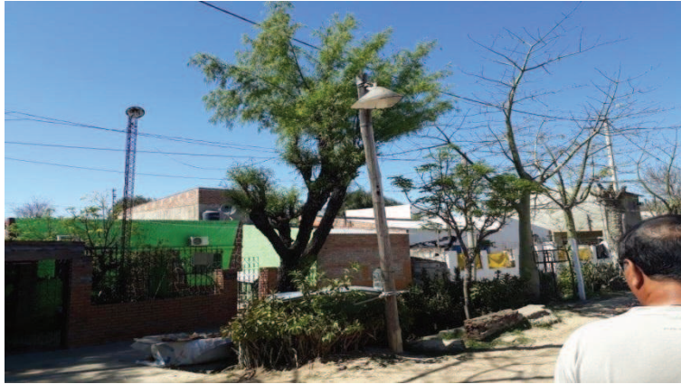
Fuente: Elaboración propia Alumbrado Público Actual Defensa Exterior Transitable 2019
