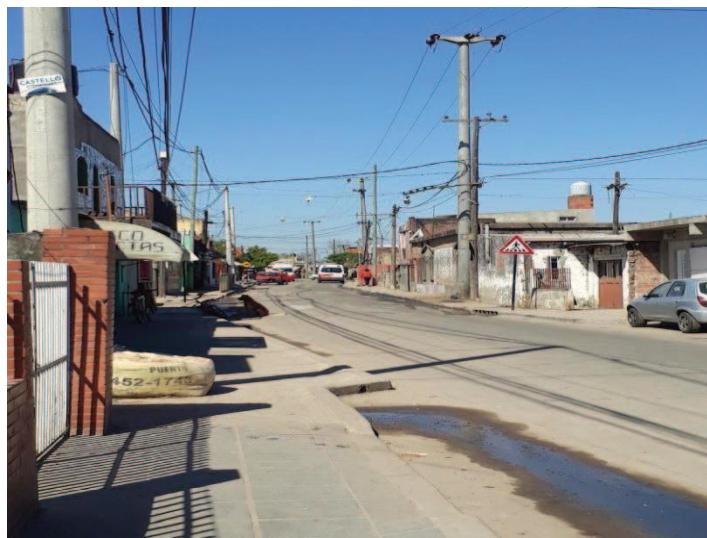
Fuente: Elaboración Propia Alumbrado Público Calle Principal Demetrio Gómez 2019
