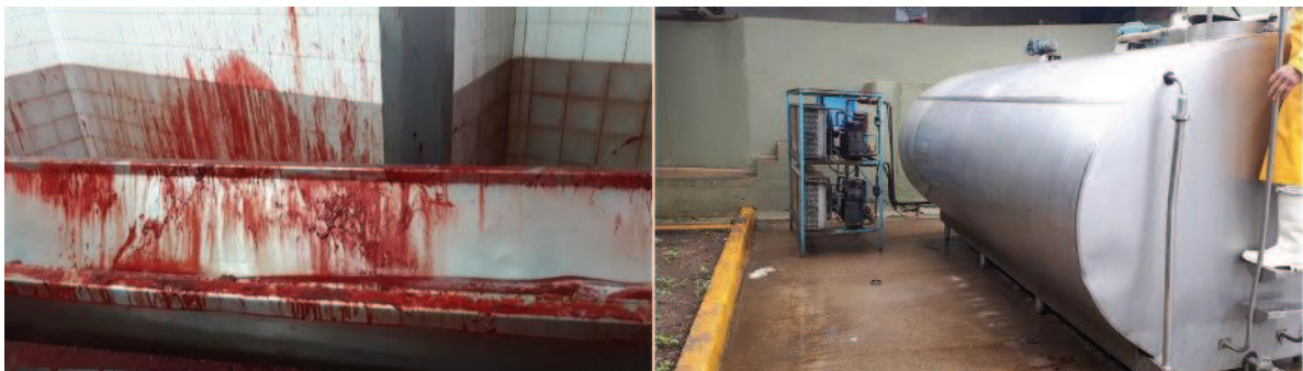
Foto 1: Captación y acumulación de sangre de primera
