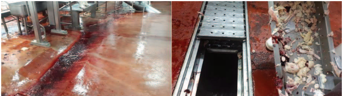
Foto 3: Captación y circulación de efluentes de lavado en zona de faena
