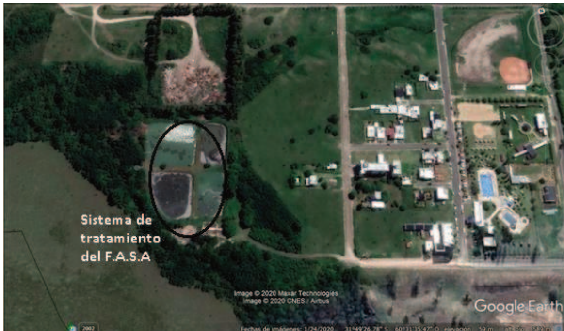
Figura 1: Tratamiento lagunar del frigorífico
