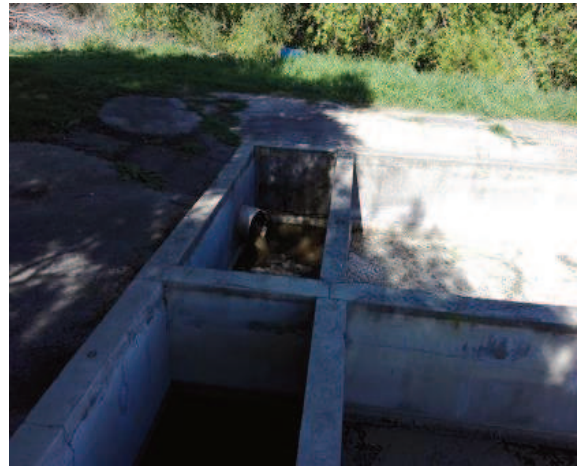
Sitio 2 (M2): Ingreso al tratamiento primario Coord. S 31°49'28", W 60°31'38"
