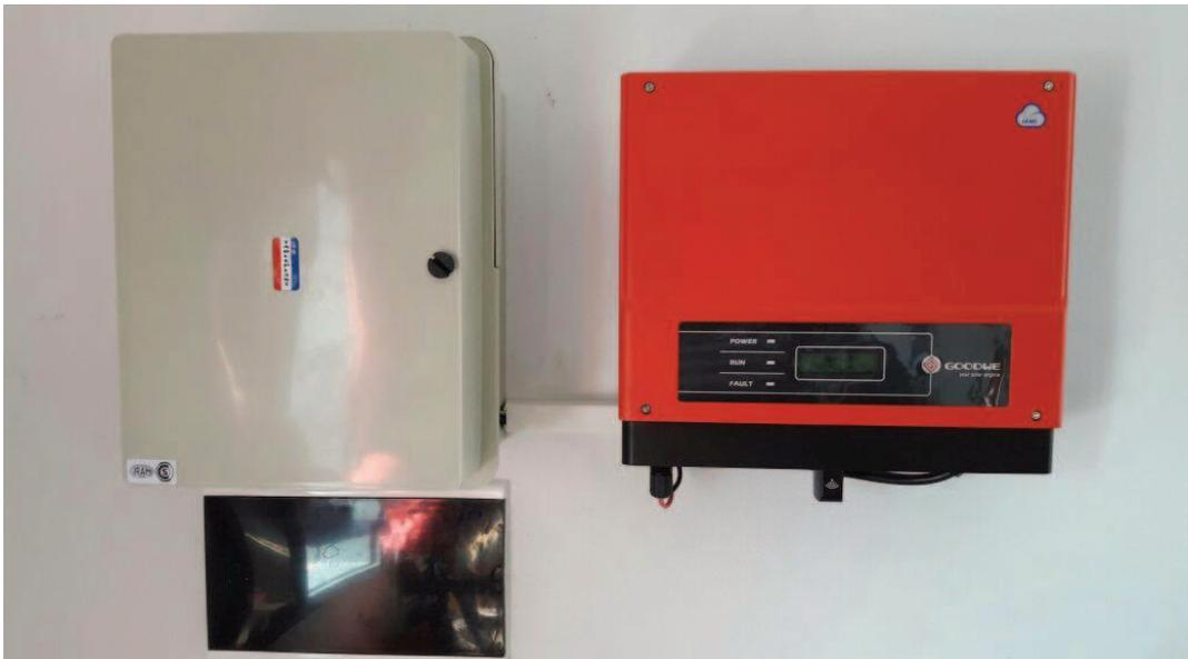
Fig. 84: Instalación de inversor y tablero de controles en las viviendas.
