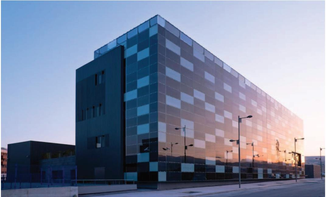
Fig. 19: Fachada fotovoltaica del Edificio Genyo en Granada, España.
