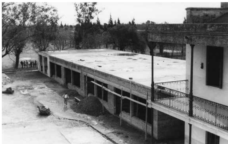
Obras de ampliación del Colegio San José. Esperanza, ca. 1963. Colección Archivo Colegio San José.
