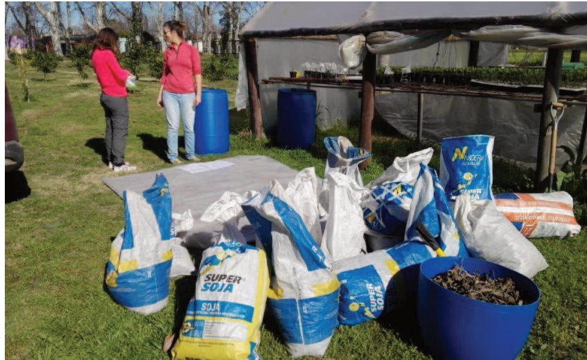
Figura 38: Disposición de los materiales para la construcción
