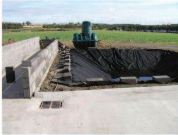
Figura 11: Cama biológica indirecta en construcción.
