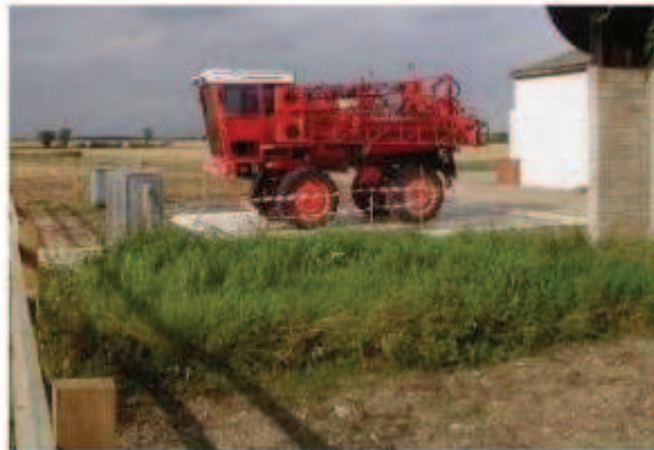
Figura 10: Una máquina fumigadora estacionada sobre una plataforma impermeable por la que escurre el líquido hacia la cama biológica indirecta
