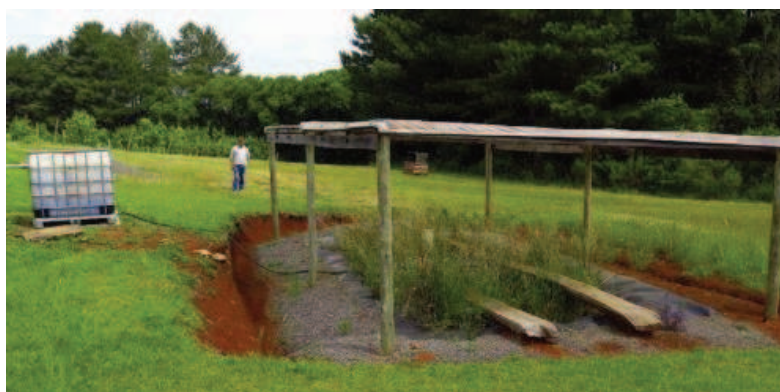
Figura 13: Cama biológica indirecta instalada en Brasil.
