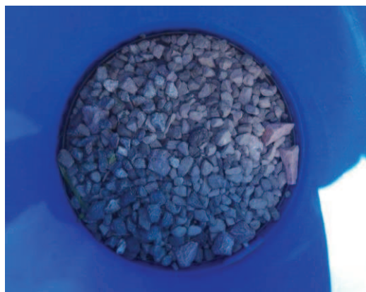
Figura 40: Disposición de grava gruesa sobre la base
