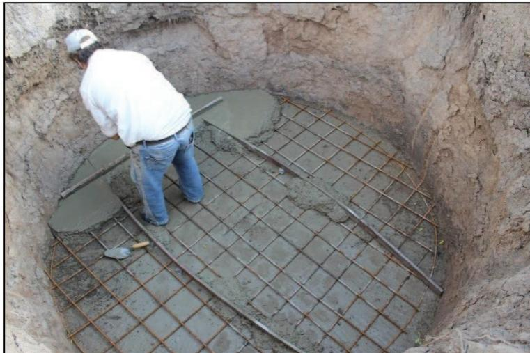
**Figura 26:** Construyendo la losa inferior del aljibe.
