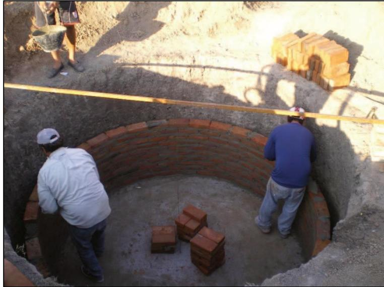
**Figura 27:** Levantando las paredes del aljibe.
