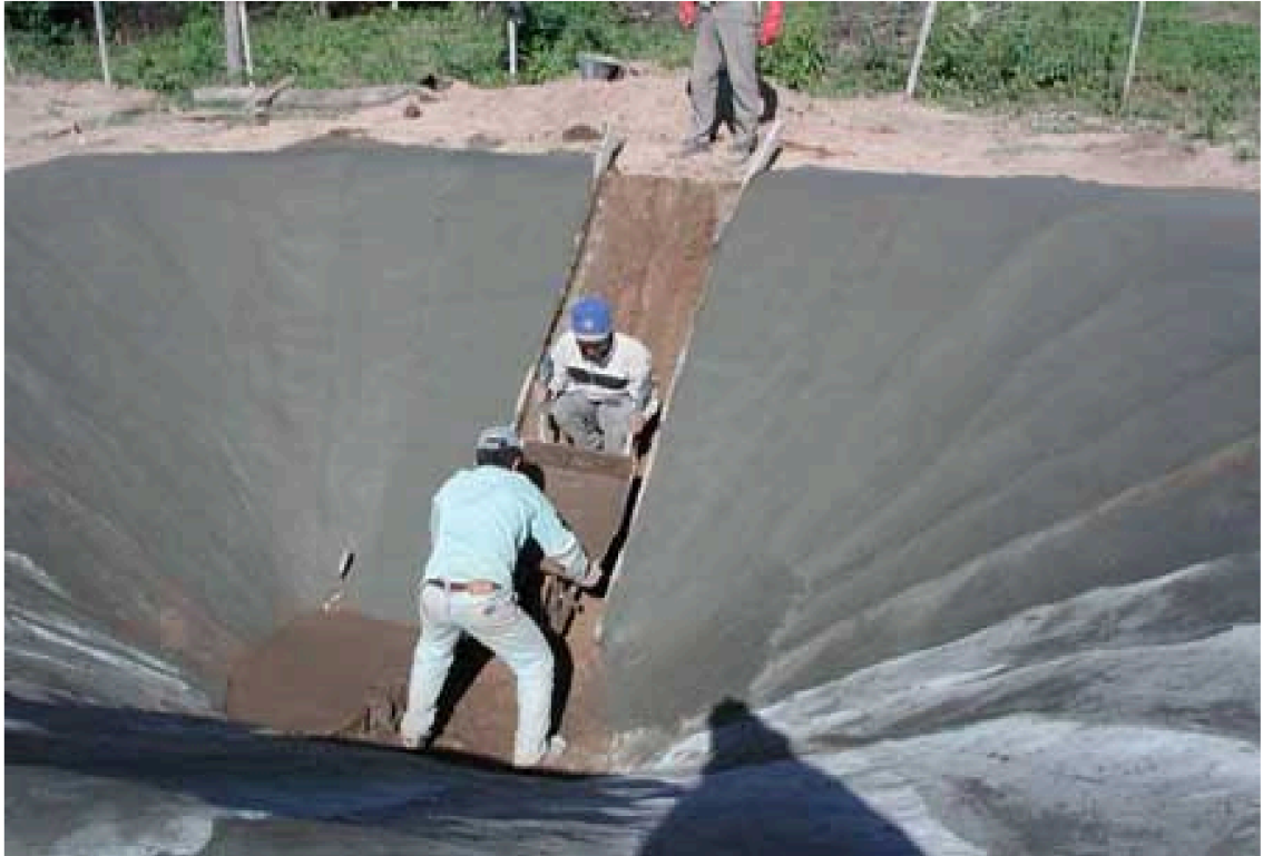
Figura 3.10: Fosa impermeabilizada en zona rural del NOA durante la etapa constructiva.
