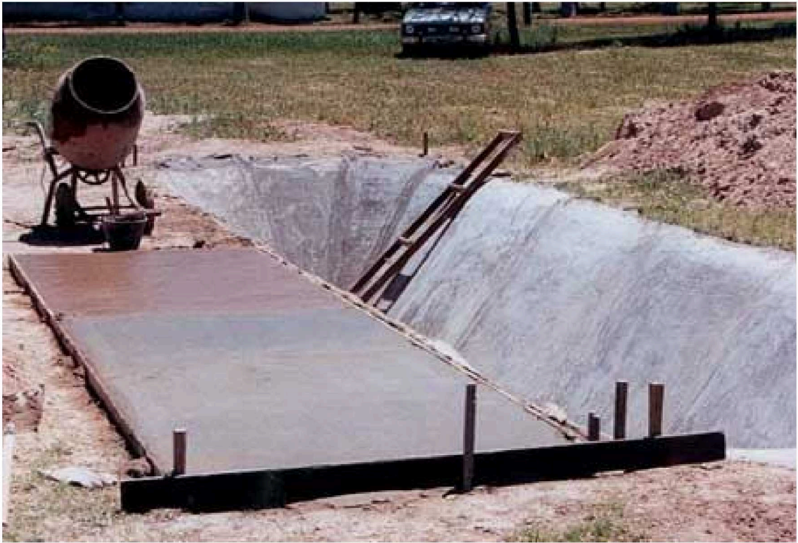
Figura 3.11: Micro-represa con suelo - cemento.
