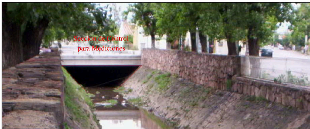
Figura 5.15: Canal Esteco en calle Alvarado. Vista hacia el Norte.
