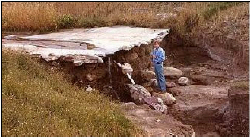
Figura 3.8: Degradación típica de un curso de agua en el área de Denver después de un proceso de urbanización (Wulliman and Urbonas, 2005).
