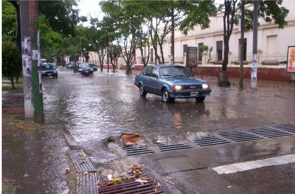
Figura 5.21: Boca de tormenta existente en la intersección de las calles Belgrano y Alvear.
