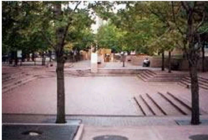
Figura 3.4: Dispositivo de detención construido en espacio público.
