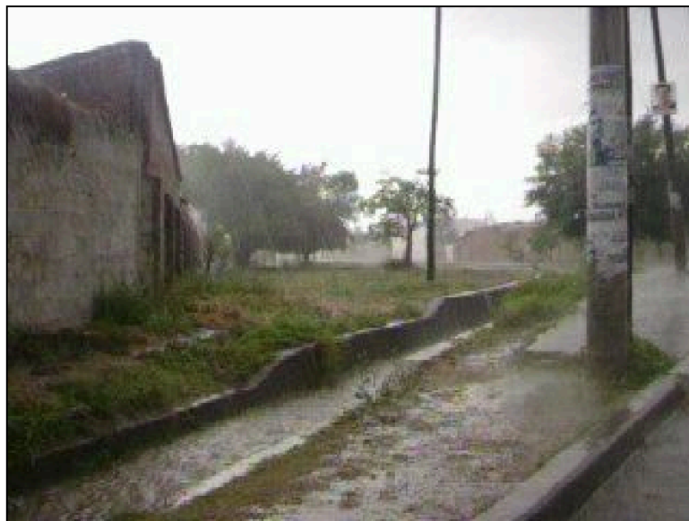
Figura 5.17: Canal de cruce pluvial bajo ferrocarril sobre calle España.
