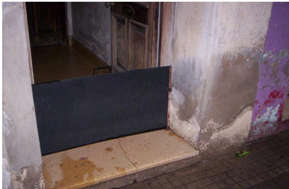
Figura 5.19: Vista de una compuerta manual implementada en un acceso a vivienda.
