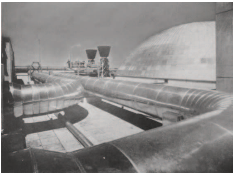
Figura 10: Central Atómica ATUCHA I. Vista de la cúpula del edificio del reactor y las tuberías hacia las salas de seguridad. Fuente: Revista Nuestra Arquitectura N° 481 (enero-febrero 1971:20).
