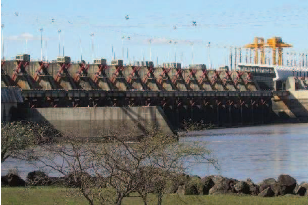
Figura 8: Represa de Salto Grande. Compuertas. Fuente: Wikipedia. Recuperado de: https://upload.wikimedia.org/wikipedia/commons/d/d7/Compuertas_de_la_represa_de_Salto_Grande.jpg
