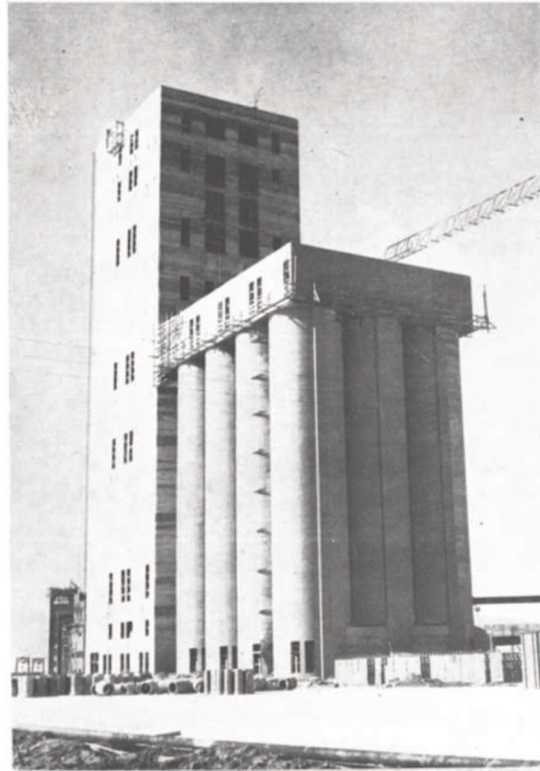
Figura 33: Elevador de granos en San Nicolás. Edificio de manipuleo y silos de almacenamiento. Fuente: Revista Nuestra Arquitectura n° 484 (1973:45).
