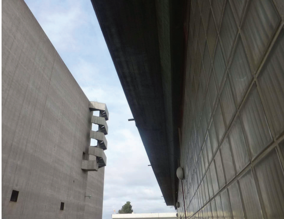
Figura 69: Central térmica Alto Valle. Escalera en sala de máquinas y pared de ladrillos de vidrio en los laboratorios. Créditos: Camila Costa (2019).
