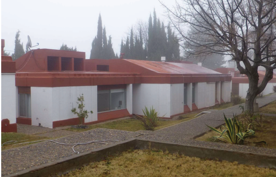
Figura 64: Viviendas de Villa El Chocón. Créditos: Camila Costa (2019).
