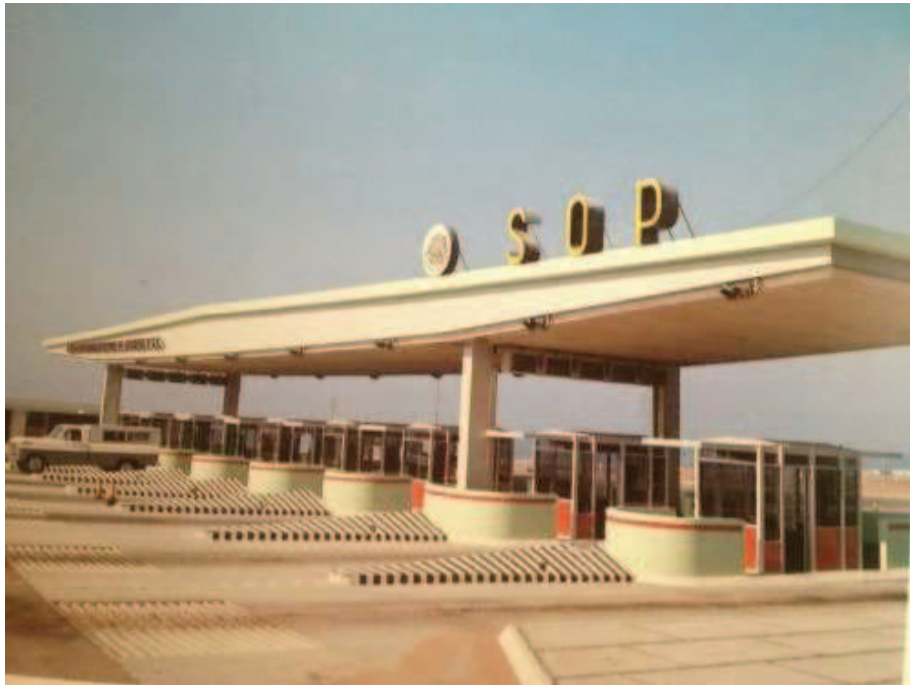
Figura 27: Cabinas de Peaje en Puebla (Puebla, México). Vista del conjunto (c.1967). Fuente: Industria Mexicana Recuperado de: https://industriamexicana.tumblr.com/post/52632194519/caseta-de-cobro-de-la-carretera-m%C3%A9xico-puebla
