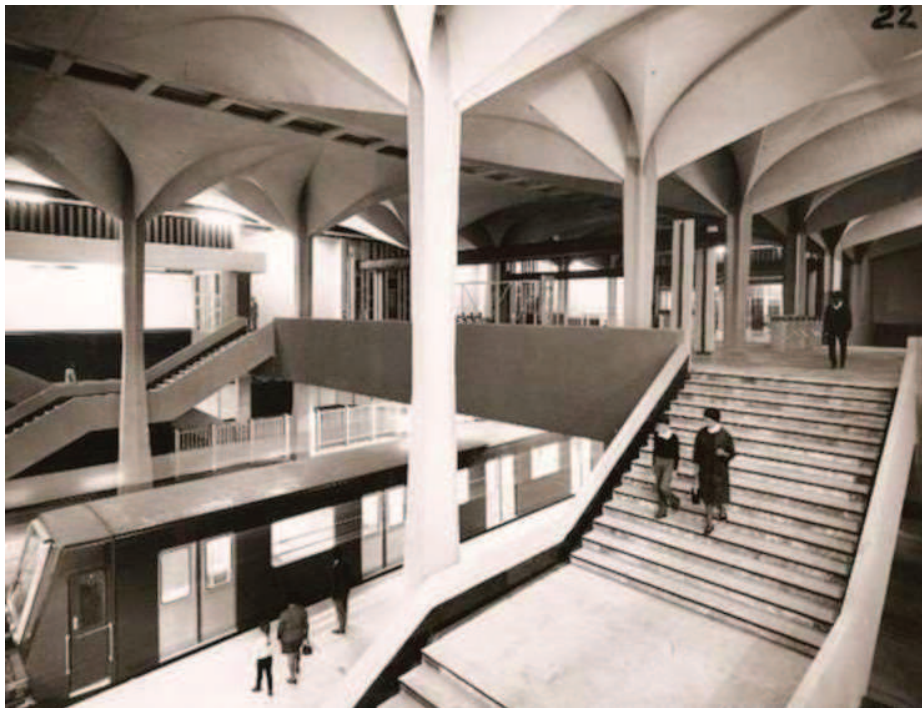
Figura 26: Estación de metro Candelaria (México DF, México). Columnas y escalinatas. Fuente: Gaxiola, M. (s/f).
