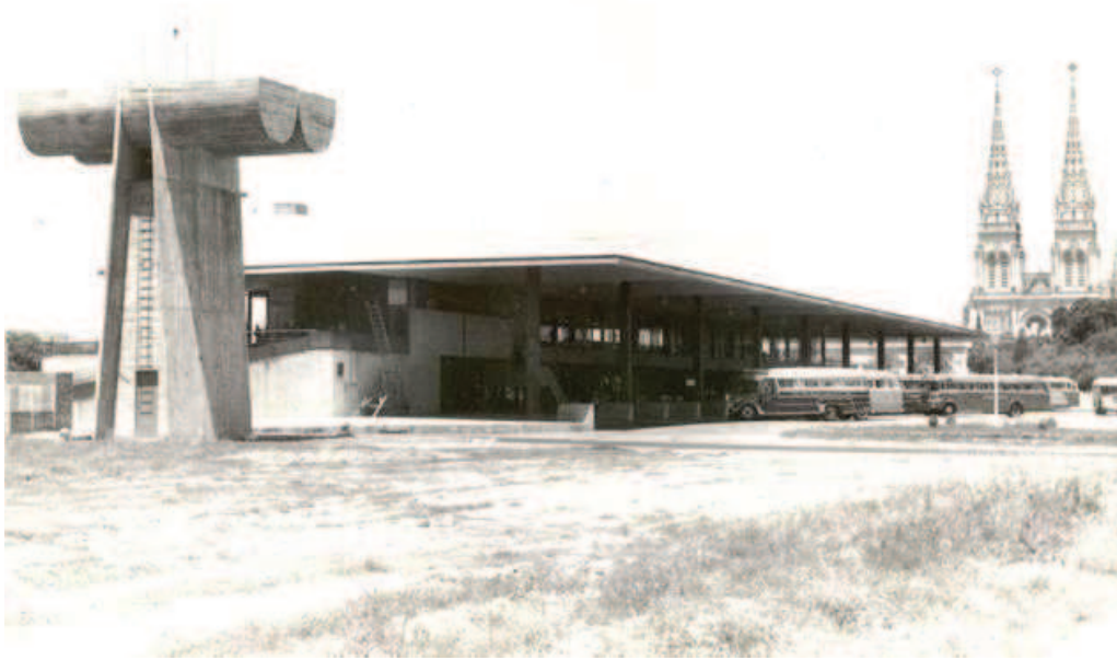
Figura 12: Terminal de Luján, vista de conjunto con la basílica de Luján al fondo. Fuente: sitio oficial estudio Urgell-Penedo-Urgell. Recuperado de: http://www.urgell-penedo-urgell.com/proyectos/categoria/000/terminal-de-omnibus-de-lujan-/
