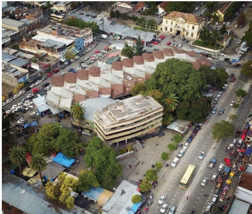
Figura 56: Terminal de ómnibus de Tucumán. Vista aérea que muestra el entramado de rombos de la cubierta. Créditos: Sky Drone Tucumán. Recuperado de: https://www.facebook.com/eltucumanoOK/photos/la-vieja-terminal-de-%C3%B3mnibus-desde-el-aire-en-octubre-se-cumplen-55-a%C3%B1os-desde-s/1790892220986331/
