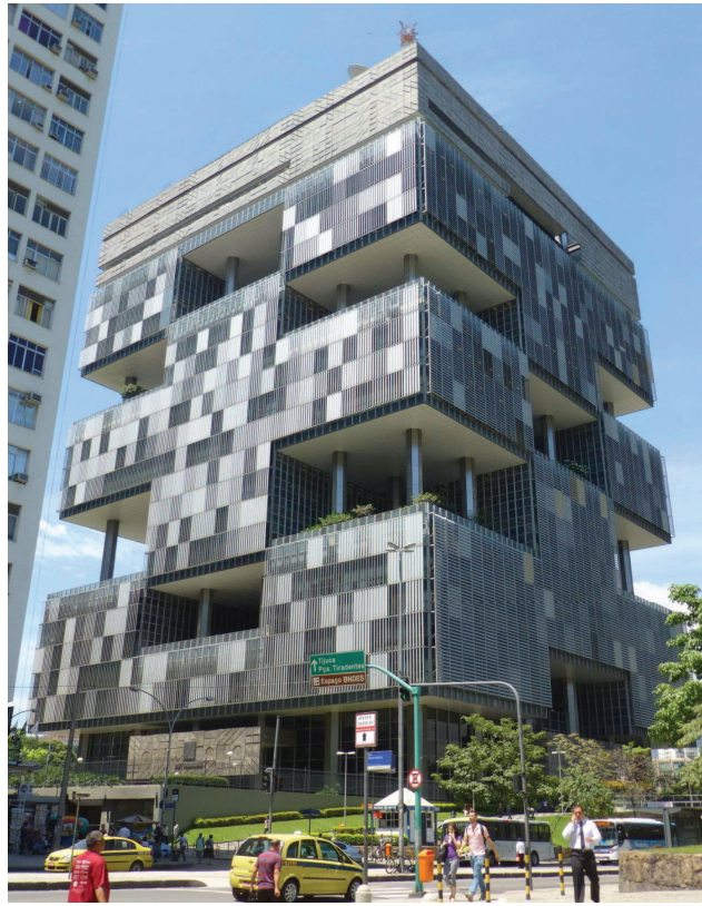
Figura 15: Edificio PETROBRAS. Vista de esquina (Río de Janeiro, Brasil). Créditos: Camila Costa (2014).
