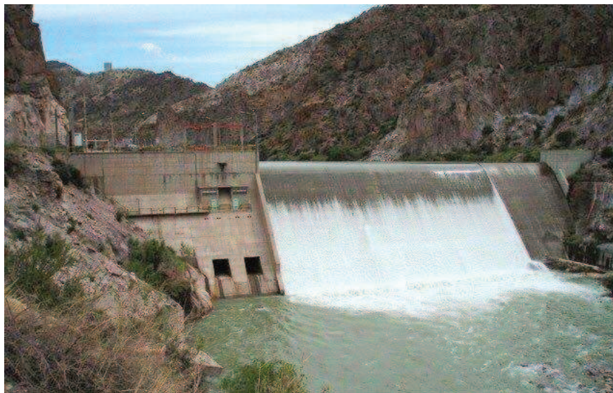
Figura 39: El Nihuil III, presa Tierras Blancas. Vertedero. Fuente: Ministerio de Obras Públicas.
