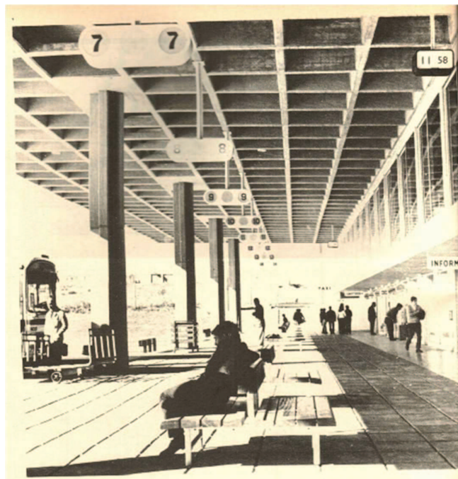
Figura 46: Terminal de Tandil. Sector de andenes. Fuente: Summa nº185 (1983:30).
