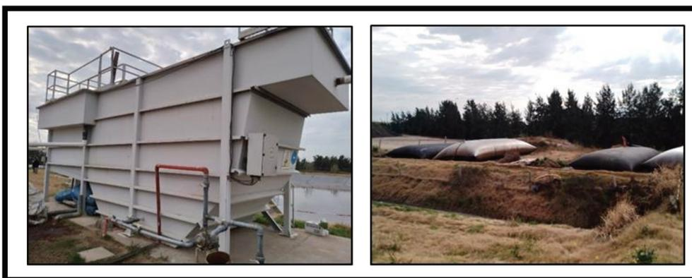
**Figura 3.2. Sedimentador y sistemas de geotubos de deshidratación de lodo**
