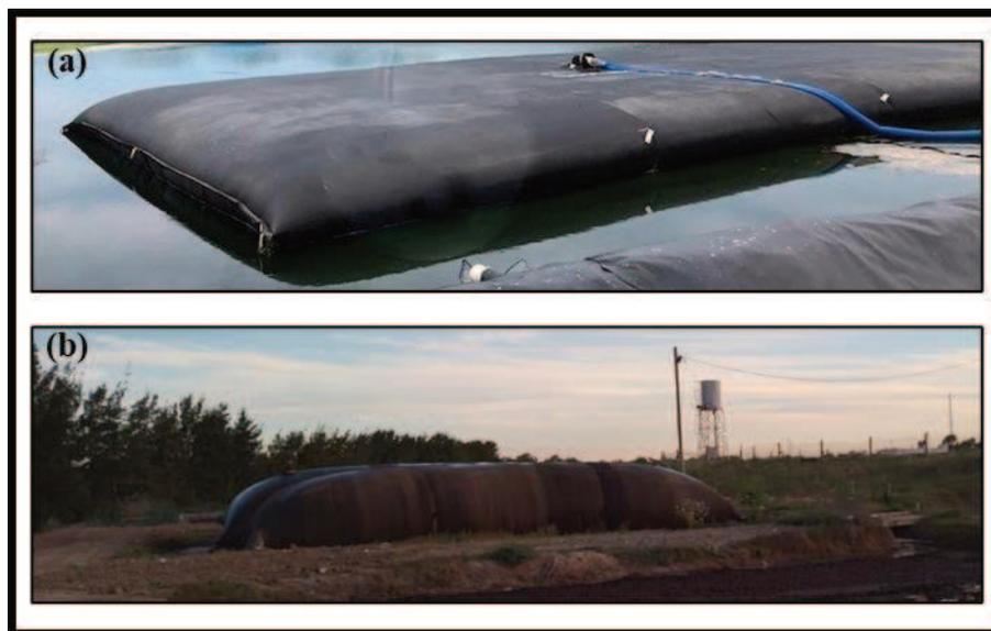
**Figura 2.3. Geotubo de deshidratación de lodos (a) en escala piloto (b) en funcionamiento a escala real**
