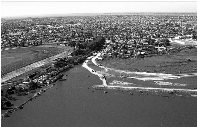
Imagen 19. Vista Extremo defensa erosionada - El Litoral - Eduardo Salva.
