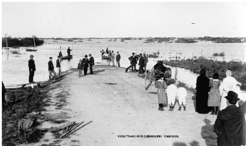
Imagen 1. Inundación de 1914, Zona Puente Mihura Camino a Esperanza.
