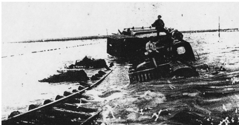
Imagen 3. Inundación 1914. Zona San Cristóbal. Descarrilamiento. Pericia judicial causa inundaciones. Fuente: Revista del Centenario de San Cristóbal.
