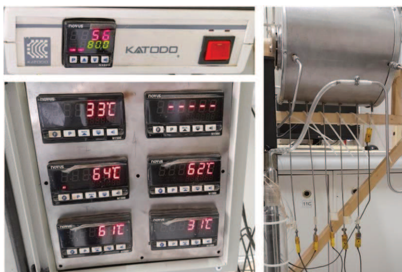
Figura 4.3. Termocuplas, lectores de temperatura y controlador.
