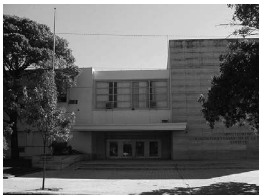
Figura 81 Vista general del acceso del “Instituto de Investigación y Fomento Agrícola Ganadero”
