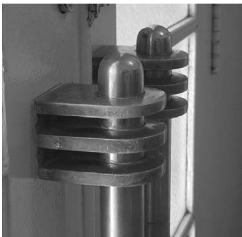
Figura 17 Escuela "Cristóbal Colón". Detalle herrajes puerta de ingreso
