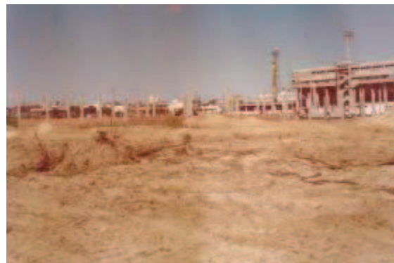
Diciembre 1979. Instalación de la planta de premoldeados. Archivo DPVyU / Preparación de los terrenos de la manzana 12, lindante con el Club Atlético Colón. Archivo Monti.
