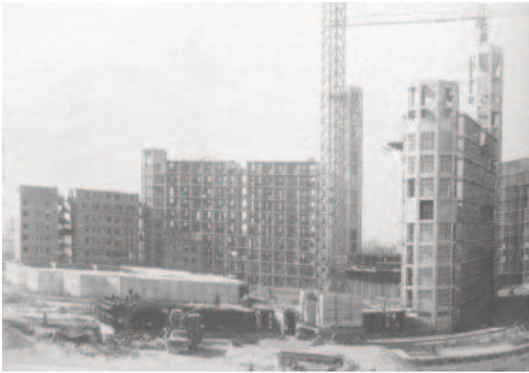
MSGSSV. Conjunto Piedrabuena en construcción. Constructoras: Aslan y Ezcurrea SA, DyCASA, Petersen, Thiele y Cruz SA. Summa nro. 113 junio 1977.
