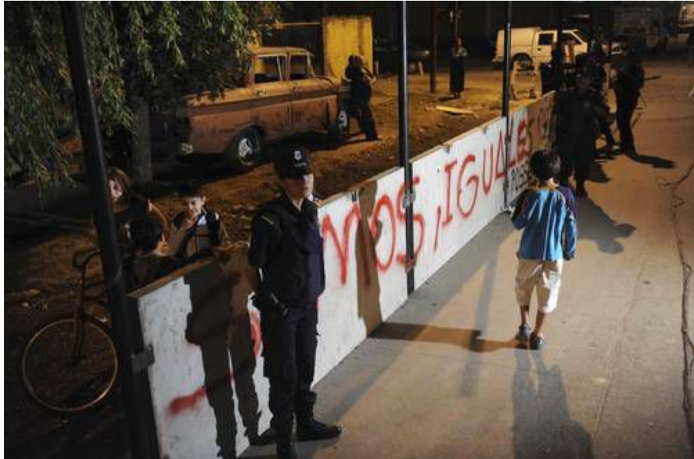
Fotografía 25. Construcción de un muro que divide que separa a vecinos de la Villa Jardín en el Municipio de San Isidro con los vecinos del Municipio de San Fernando.
