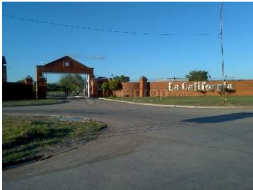
Fotografía 18. Ingreso al barrio privado “la California”.
