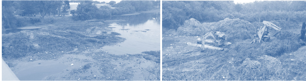
Fotografía 9. Tapamiento Natural del Río Negro por sedimentación. 2013
