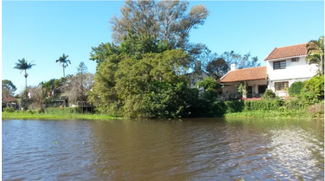
Fotografía 23. Situación actual, casa construida sobre la ribera.
