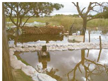
Figura 16: Bolsas de arena para conectar una casa al camino. Fuente: Archivo personal
