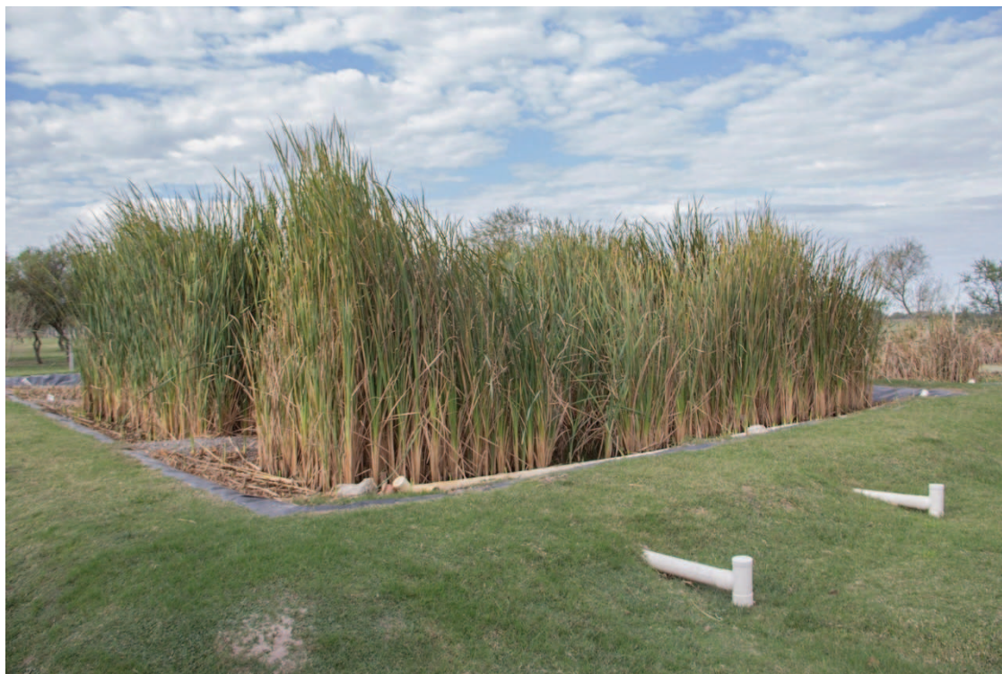
Fig. 17. Fotografía de un HT de flujo subsuperficial horizontal construido en una industria real el cual fue monitoreado previamente por el equipo de trabajo.
