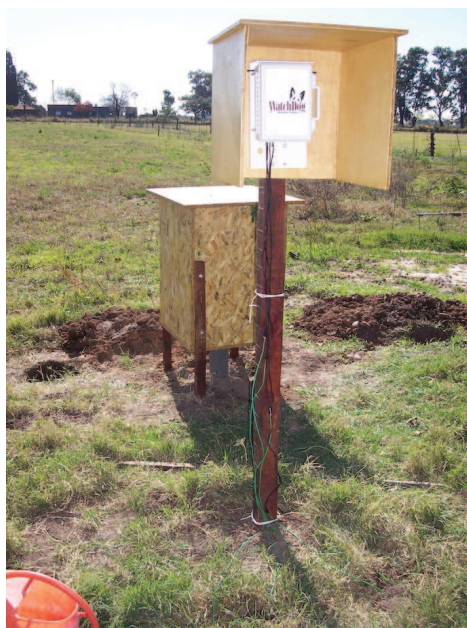
Figura 4.6: Instalación de sensores Watermark y datalogger en Santo Domingo.
