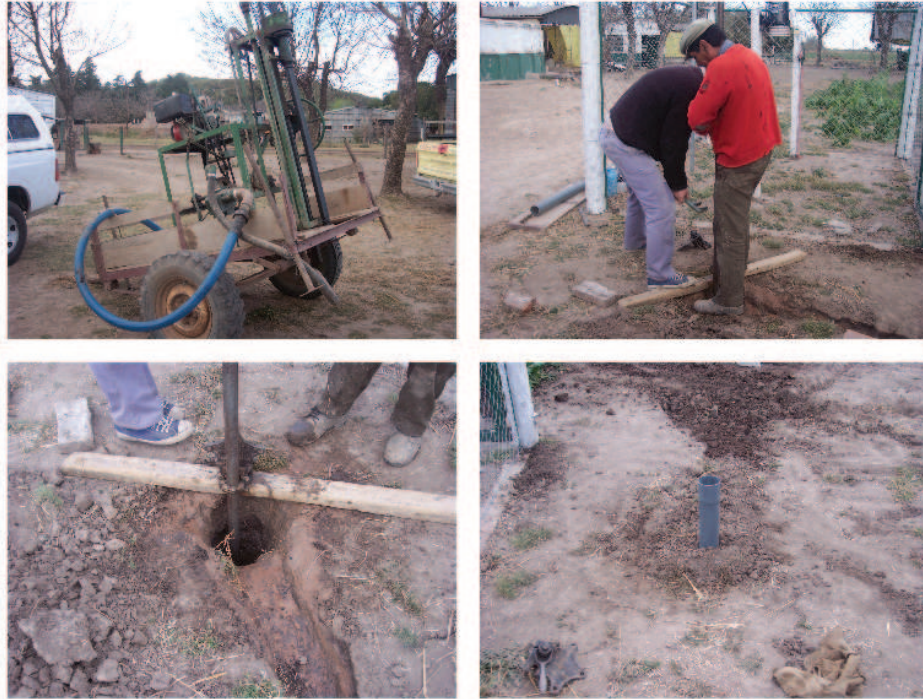
Figura 4.9: Perforación realizada en Ataliva.
