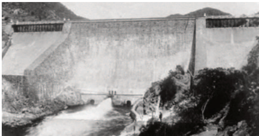
Figura 5.4: Primer Dique San Roque (1890)
