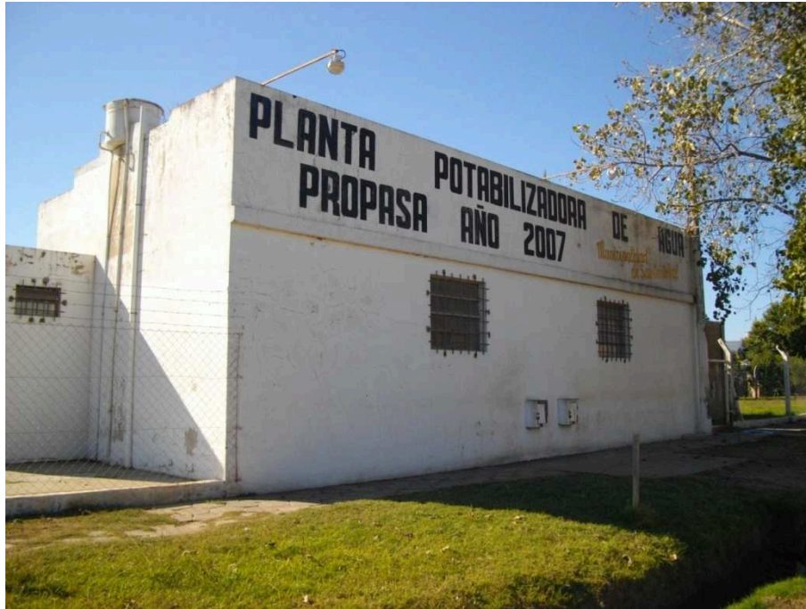
Figura 14. Planta Potabilizadora de agua de la Municipalidad de San Cristóbal.
