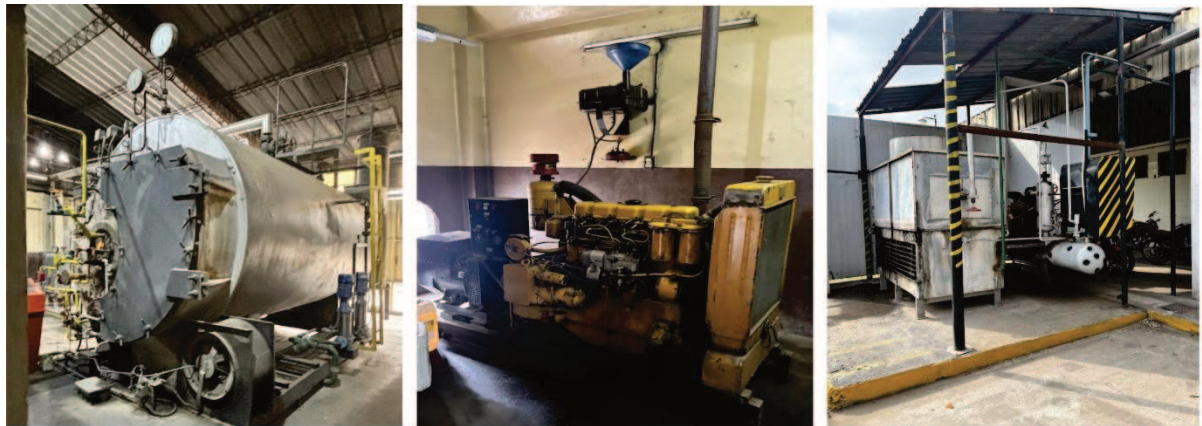
Caldera, intercambiador de aceite y equipos de frío.
