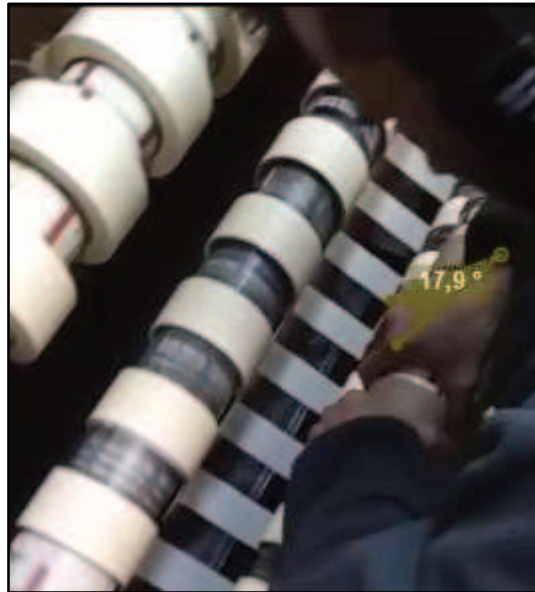
Figura 22 Tarea N° 03 reemplazo de canutos
