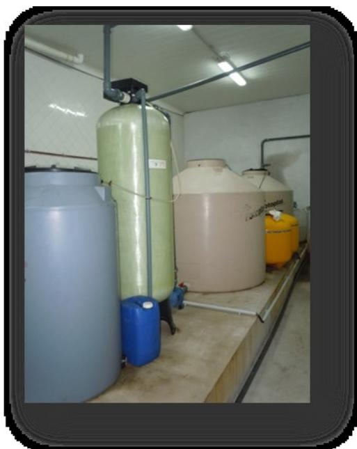
Foto 14. **Equipo potabilizador del agua.**
